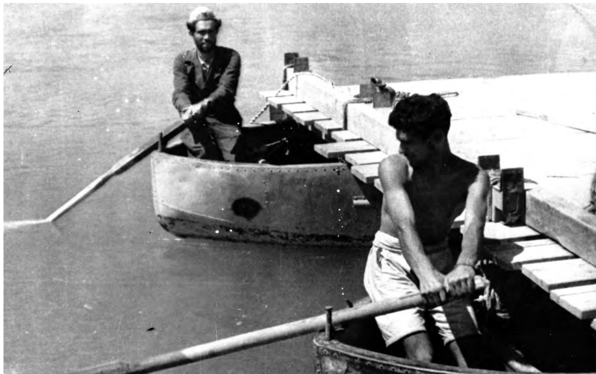
Dos pontoneros en barca, ayudan a la colocación de los tramos de un puente.
