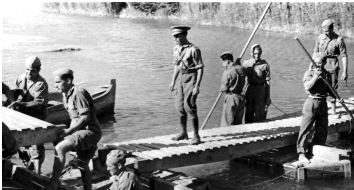
Construcción de un puente sobre el río Ebro.
