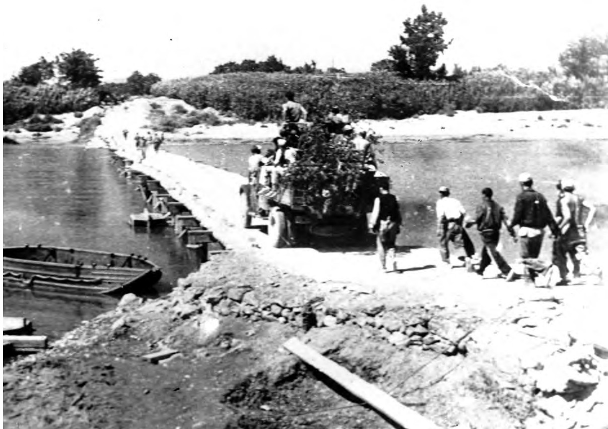
Camión y pontoneros comprobando la firmeza del puente para el paso de tropas.
